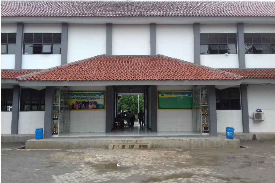
Foto gedung utama sekolah yang menghadap langsung ke arah pintu gerbang sekolah, dimana terdapat sebuah ruang lobby yang berada di tengah gedung
