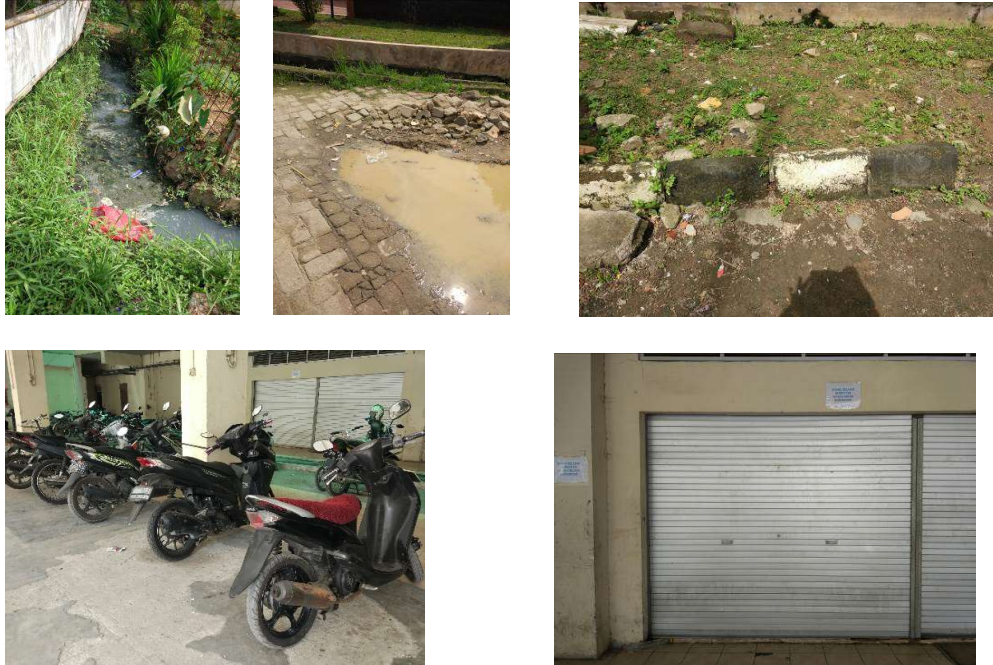
Gambar 1.2 Kondisi Sarana, prasarana dan utilitas umum Rumah Susun Komarudin
