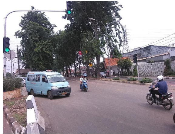
Gambar 1.2. Kondisi Jalan Raya di Persimpangan Tiga
