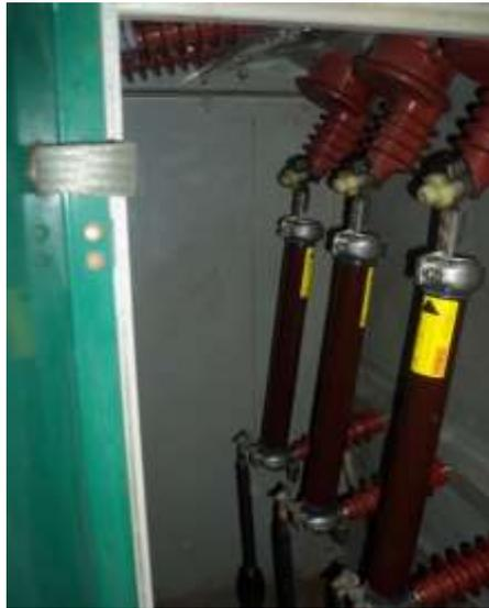
Gambar 2.5 *Solefuse* dalam melindungi trafo tegangan
