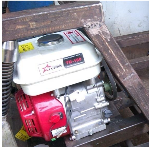
Gambar 3.20 Proses Pemasangan Motor Bensin
