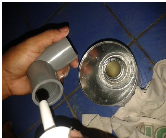
Gambar 3.11 Memberikan lem pada elbow 90^{\circ}
