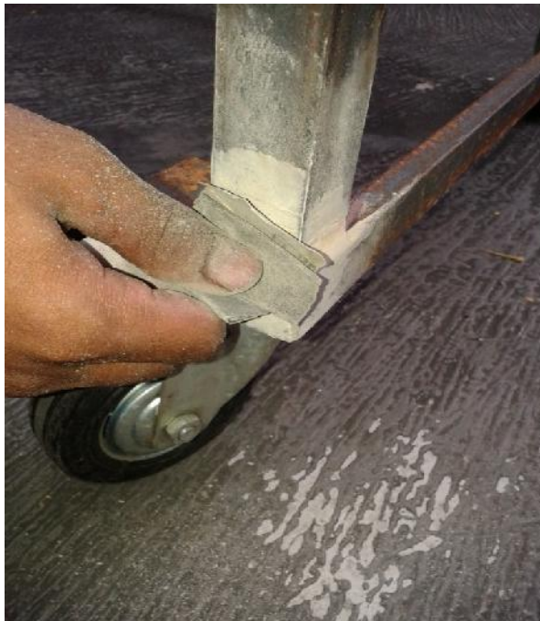
Gambar 3.5 Mengamplas bagian yang telah dilas.
