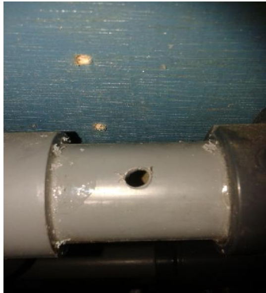
Gambar 3.17 Melubangi bagian pipa dengan ukuran 5 mm.
