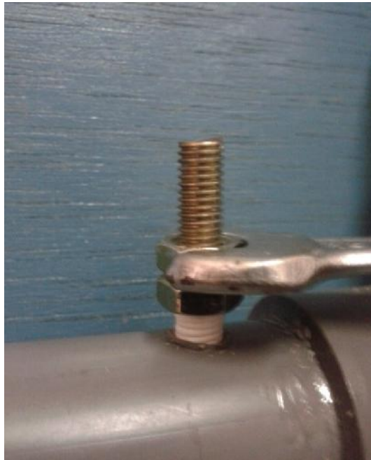
Gambar 3.19 Memasang baut sebagai penyambung selang ukur
