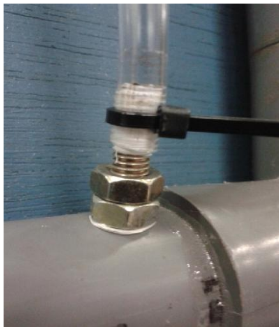
Gambar 3.22 Pemasangan insulock pada selang ukur.
