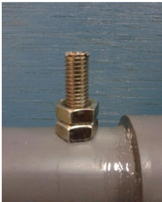
Gambar 3.20 Baut yang telah terpasang dengan baik dan benar
