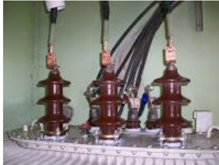
Gambar 2.12 Bushing transformator Sumber : PT PLN (Persero)
