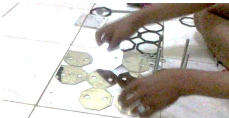
Gambar 3.19. Memasang cell plat netral (N)
