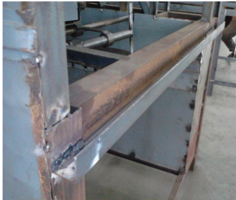
Gambar 3.44. Pemasangan sliding pintu.
