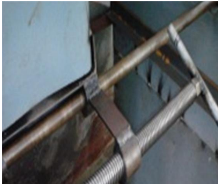
Gambar 3.30. Pemasangan poros As.
