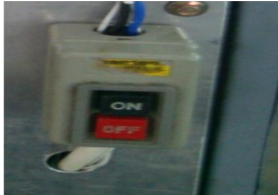
Gambar 4.4. power ON pada mesin putar.
