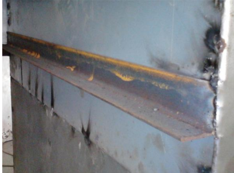
Gambar 3.41. Pemasangan rel penampung.
