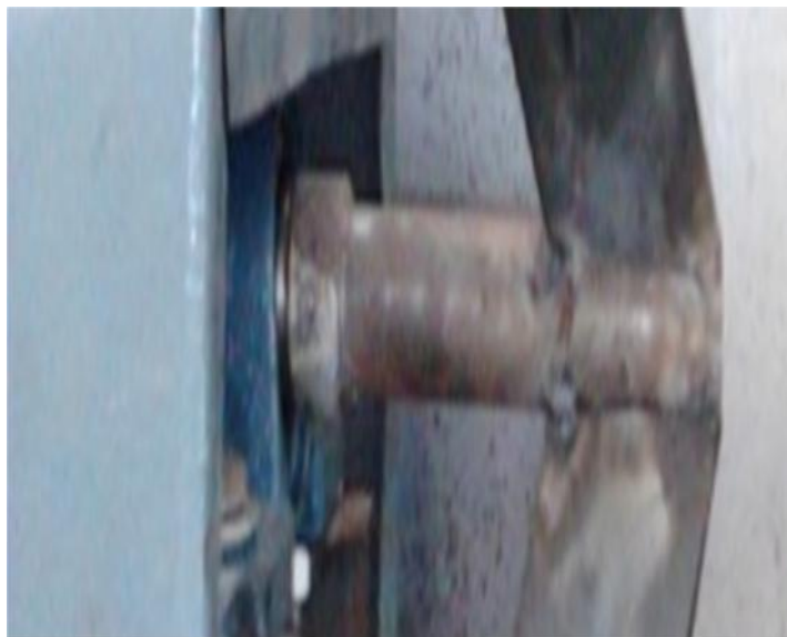
Gambar 3.32. Pemasangan poros putar.
