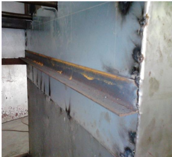
Gambar 3.40. Pemasangan cover bagian bawah.
