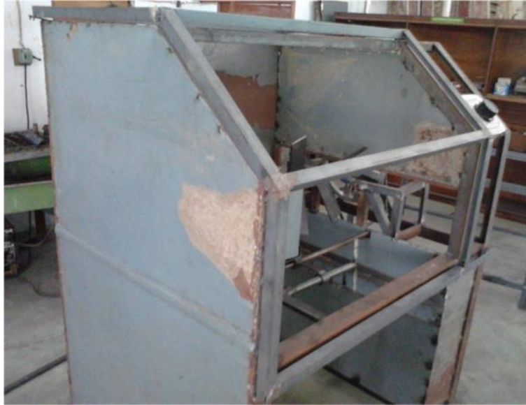
Gambar 3.43. Pemasangan kerangka pintu.
