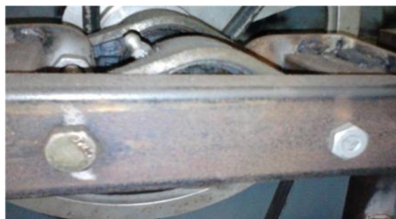
Gambar 3.20. Pemasangan mur dan baut
