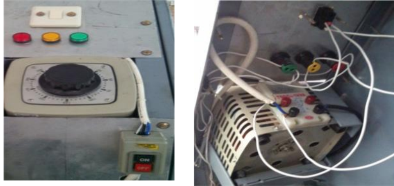
Gambar 3.53. Penyambungan dari kabel power ke saklar lampu.
