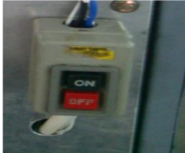
Gambar 3.47. Penyambungan kabel power.
