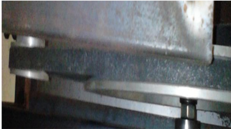
Gambar 3.23. Pemasangan pulley ke poros penggerak.
