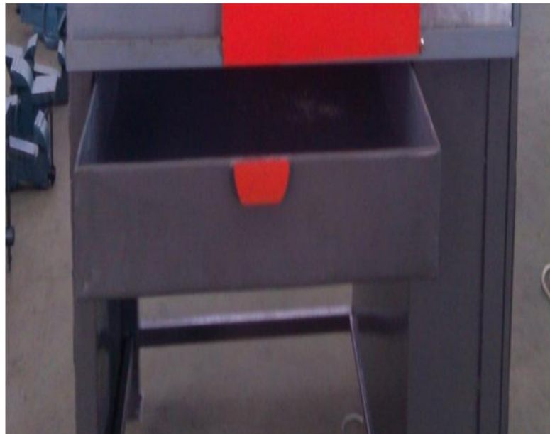
Gambar 3.42. Pemasangan bak penampung.
