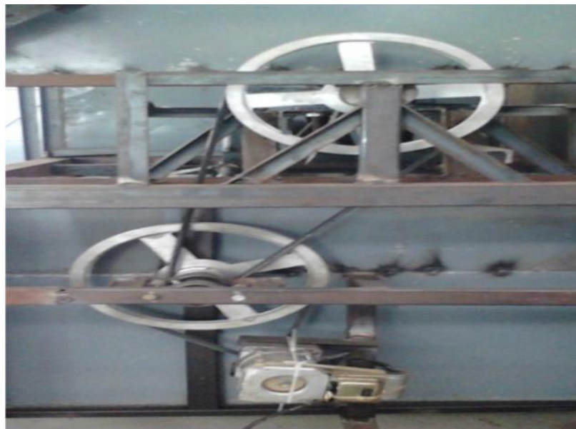
Gambar 3.24. Pemasanganudukan bearing kerangka.
