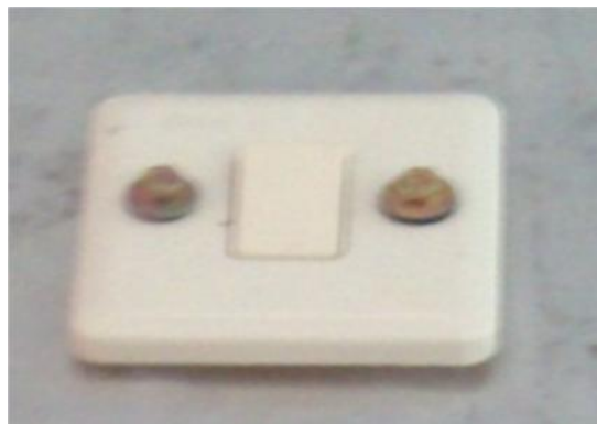
Gambar 4.5. saklar ON lampu penerangan.
