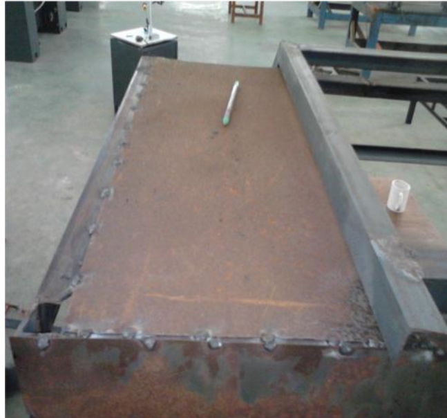
Gambar 3.37. Pemasangan cover bagian atas.
