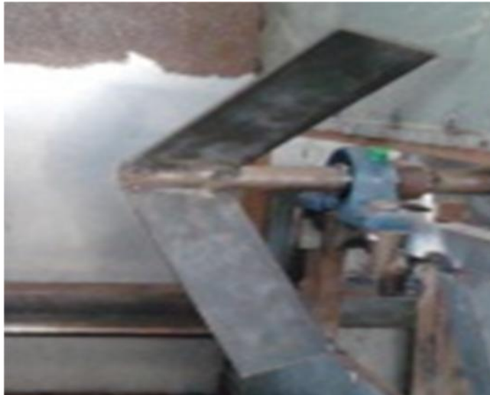
Gambar 3.29. Pemasangan plat strip keporos.
