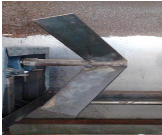
Gambar 3.34. Pemasangan plat keporos putar.
