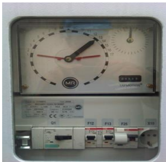
Gambar 4.1. Panel OLTC Blok 5 buatan MR
