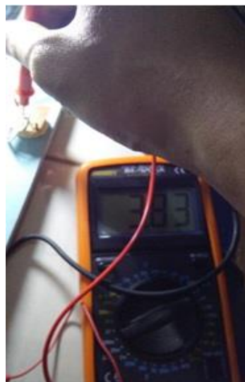
Gambar 4.4. Pengukuran Tegangan Sensor LDR Pada Ruang Teras
