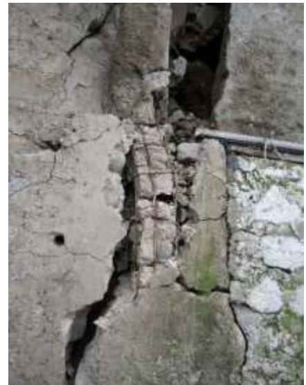
Foto3. Pondasi Beton yang rusak karena
