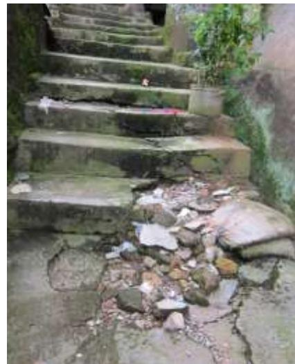
Foto 5. Akses jalan yang mengalami retak-retak,
