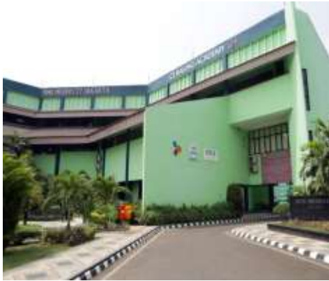
Tampak Depan SMKN 27 Jakarta
