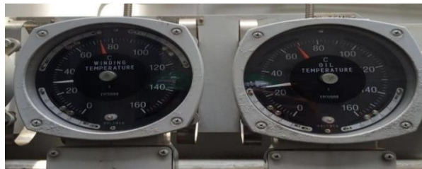
Gambar 2.8 Indikator Temperatur Minyak dan Belitan (Sumber : Dokumentasi Pribadi)
