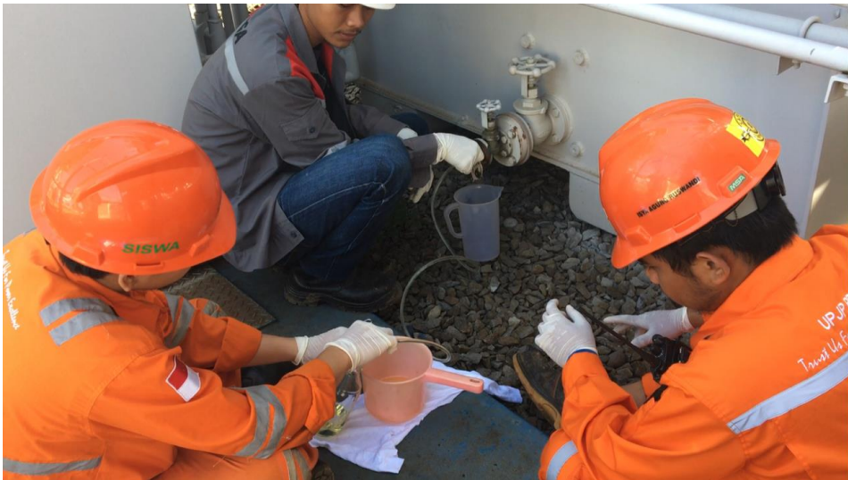
Pengambilan Minyak Transformator Bekas Pakai
