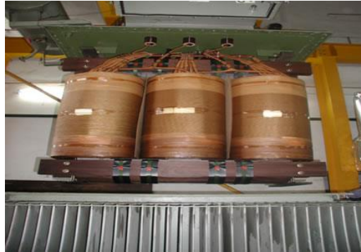
Gambar 2.3. Kumpan atau Belitan Transformator
