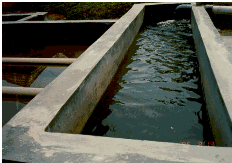
Gambar 2.2. Bak penenang pada PLTMH
