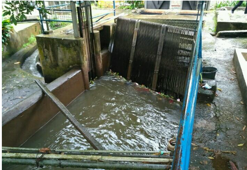
Gambar 4.11. Saluran Intake Pada Laboratorium
