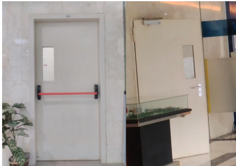
Gambar 4.17 Pintu Darurat Gedung M.Syafei
