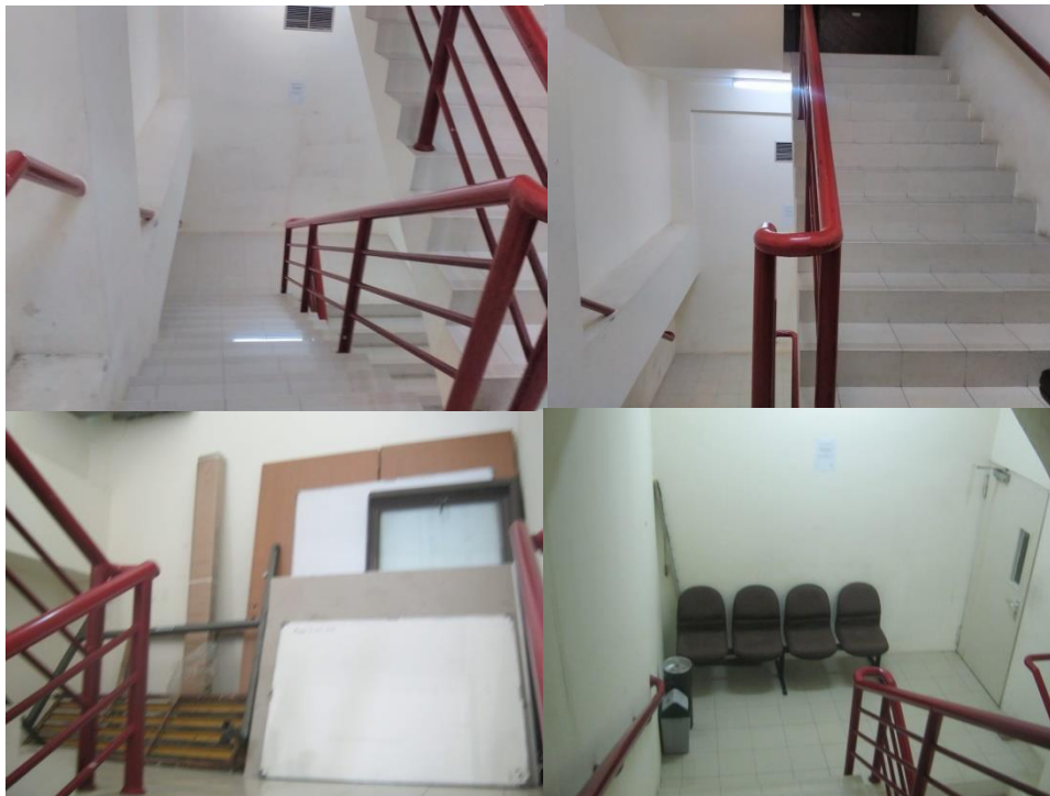
Gambar 4.14 Tangga Darurat Gedung M.Syafei
