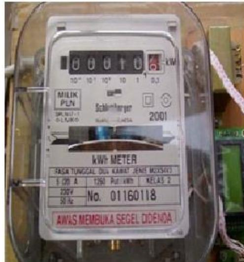
**Gambar 2.24** KWh meter Analog
