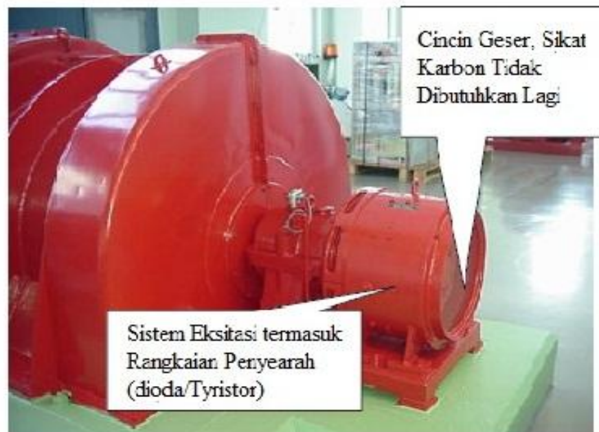
Gambar 2.4. Generator Sistem Eksitasi Tanpa Sikat
