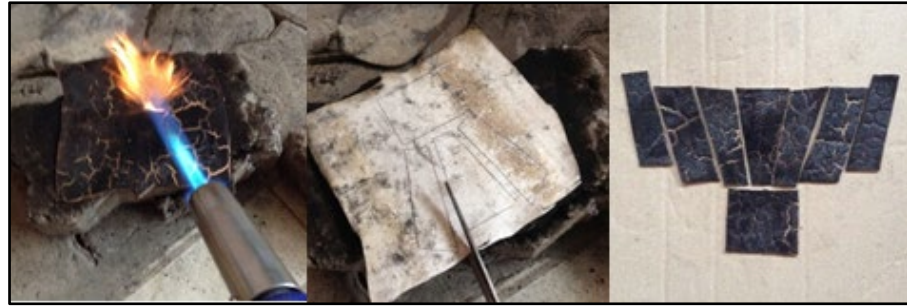
Gambar 4.34 Pembakaran pipa pvc dan pemotongan sesuai garis pola K3 (Sumber: dokumentasi pribadi)
