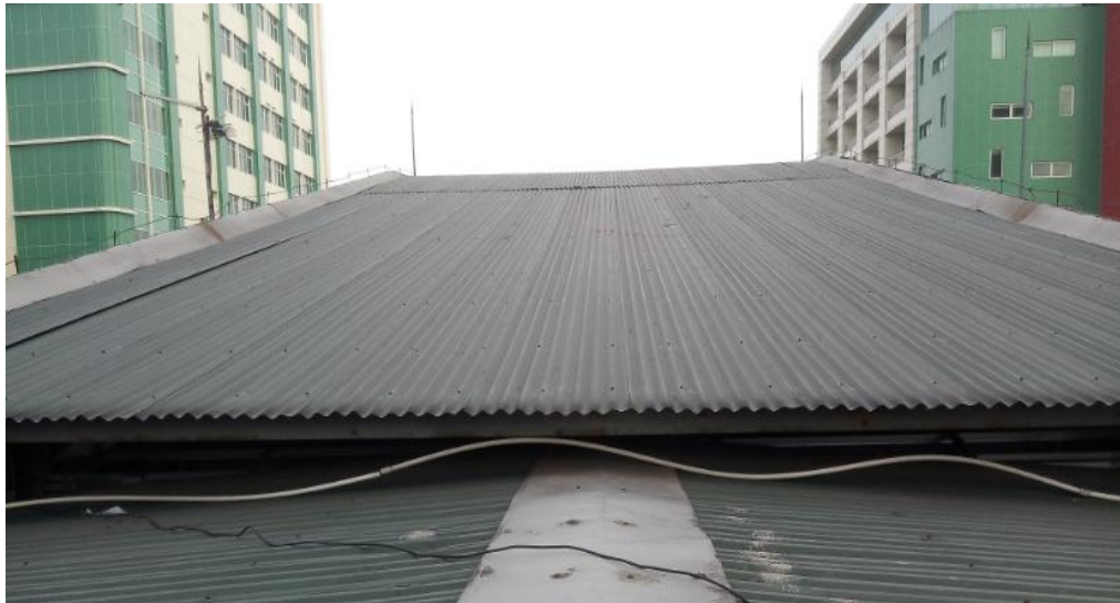
Gambar 4.8. Splitzen Penangkal Petir Gedung Rektorat
