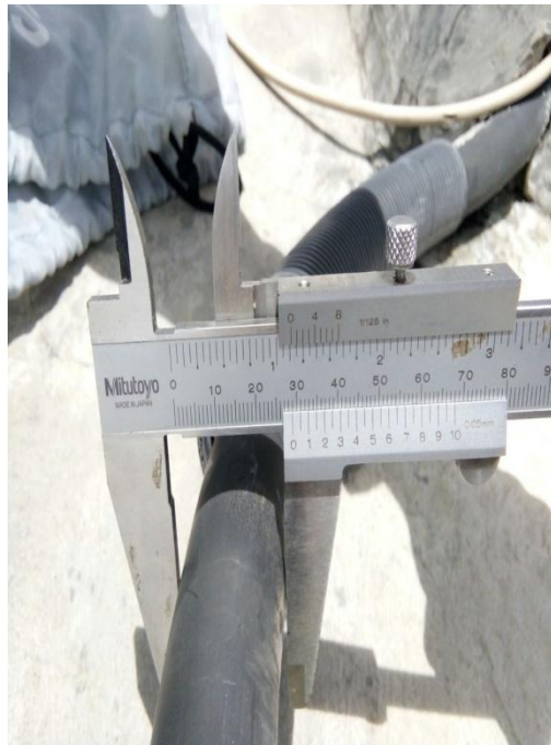
Pengukuran Diameter Kabel Konduktor
