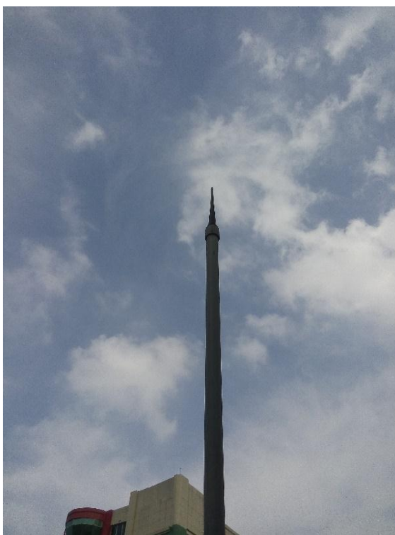
Gambar 4.10. Batang Splitzen Gedung Rektorat
