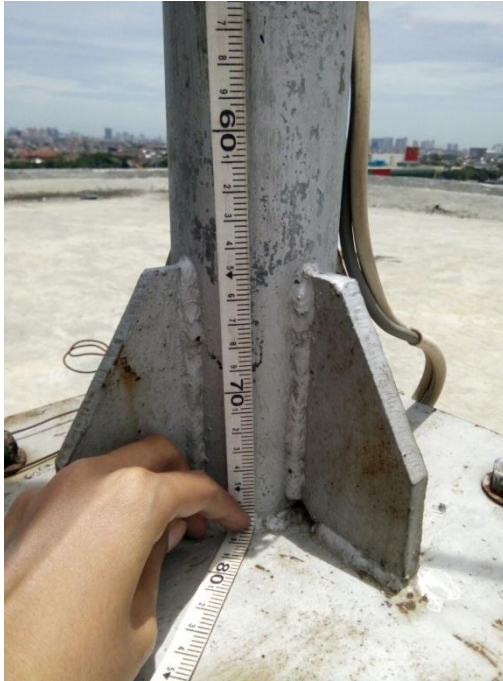
Pengukuran Tinggi Penangkal Petir
