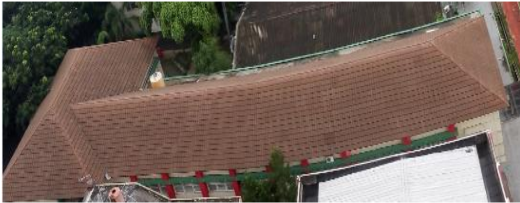
Gambar 4.30 Tampak Atas Gedung Q
