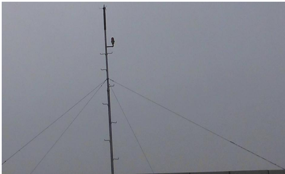
Gambar 4.16. Tiang Penyangga Penangkal Petir Gedung Raden Adjeng Kartini
