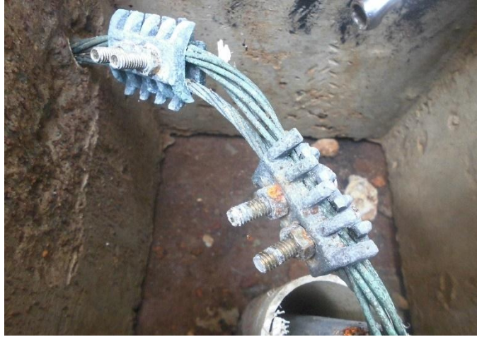
Gambar 4.19. Klem/kuku macan Penangkal Petir Gedung Raden Adjeng Kartini
