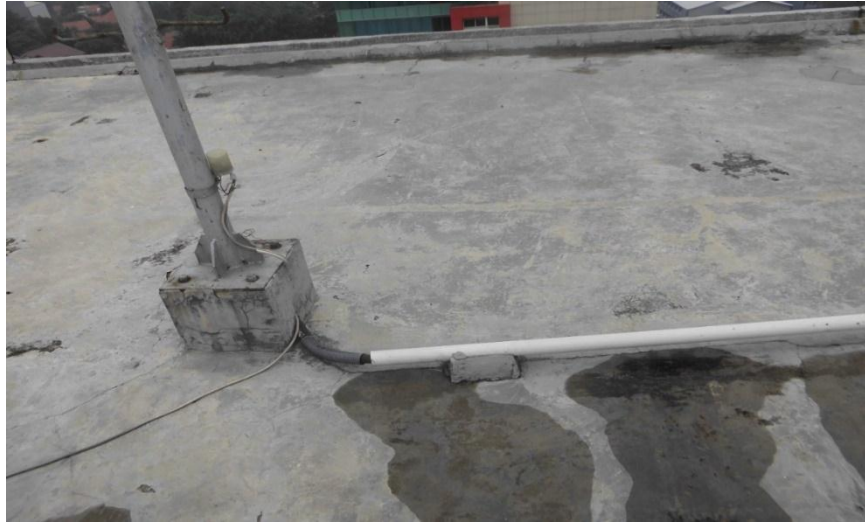
Gambar 4.22. Kabel penghantar Penangkal Petir Gedung Raden Dewi Sartika
