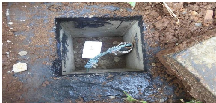
Gambar 4.18. Bak Kontrol Penangkal Petir Gedung Raden Adjeng Kartini
