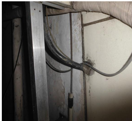
Kondisi Sistem Pentanahan (Bak Pertama)
