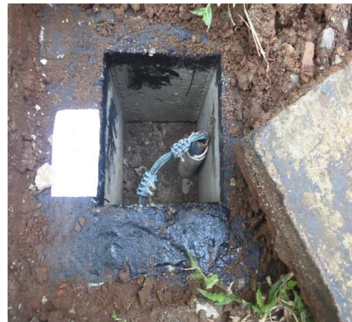
Kondisi Sistem Pentanahan (Bak Pertama)
