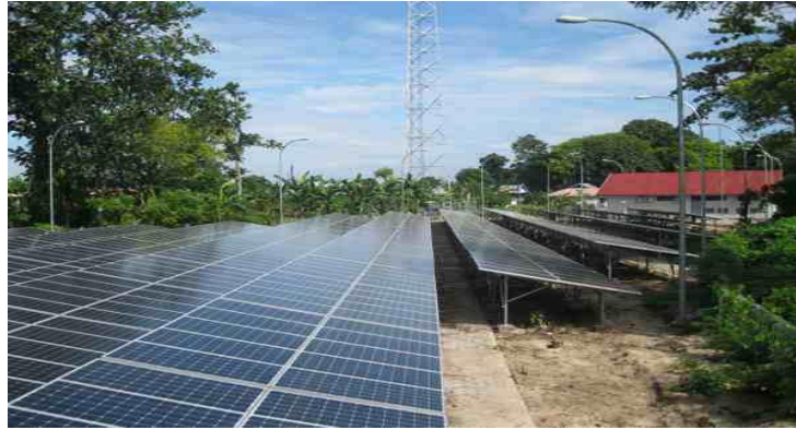
Gambar 2.2. PLTS Kabaena (Sulawesi Tenggara) dengan kapasitas 200 kW
