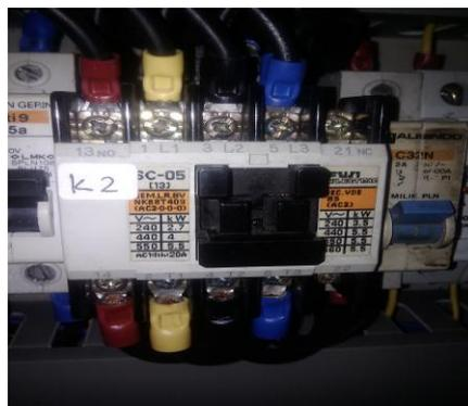
Gambar 2.13. Bentuk fisik kontaktor (*Magnetic Contactor*)
