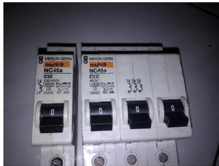
Gambar 2.16. Bentuk fisik MCB (*Miniatur Circuit Breaker*)
