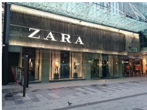
Gambar 2.4. Kanopi Marquee Toko Zara
