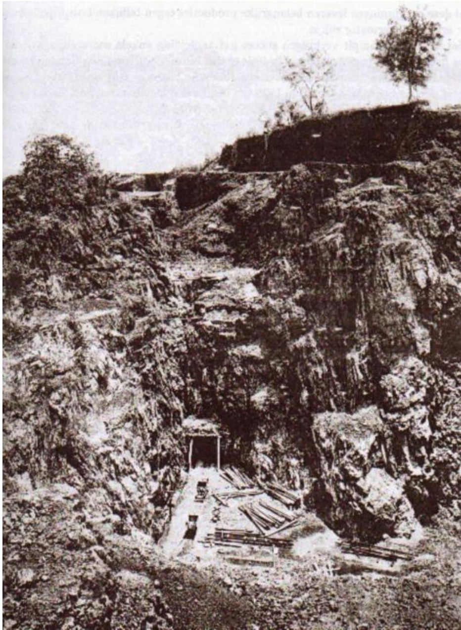
Gambar 8: Tunnel te Klapa Kampit (Sumber: Kantor Arsip Kabupaten Belitung)
