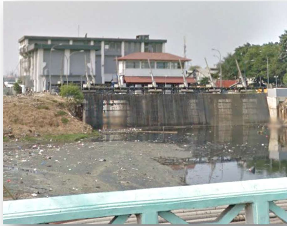
Gambar 7. Pintu Air Pasar Ikan, Jakarta Utara
