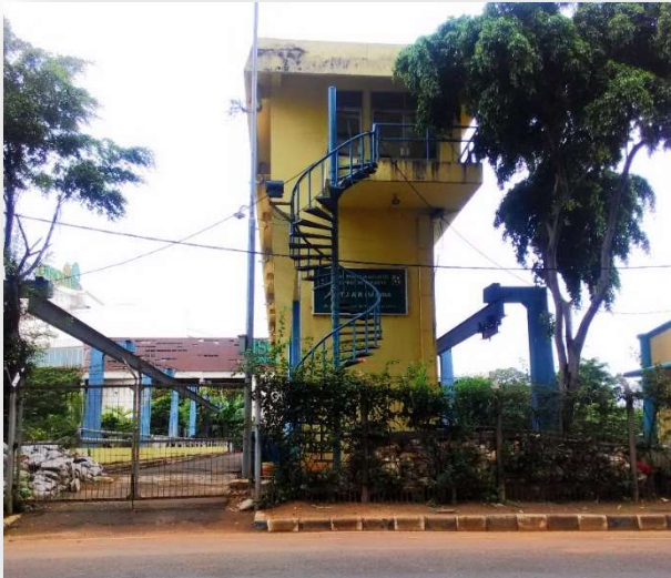
Gambar 9. Pintu Air Marina Ancol, Jakarta Utara
