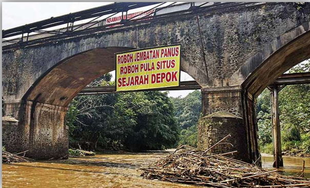
Gambar 3. Jembatan Panus, Depok
