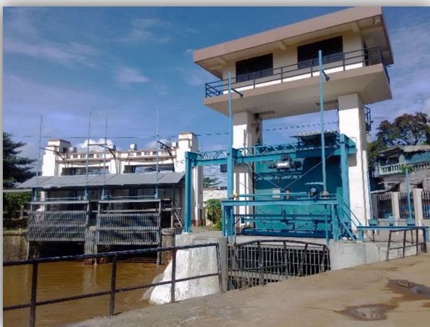
Gambar 5. Pintu Air Manggarai, Jakarta Selatan
