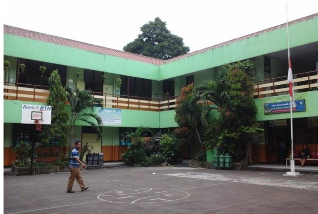
Gambar 2.1 Kondisi Gedung Sekolah
