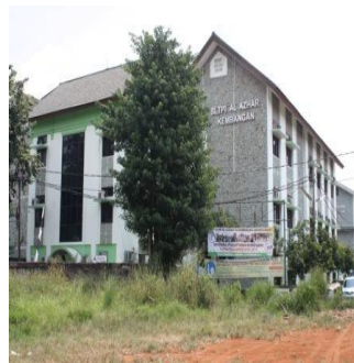
Gedung SMP/IA 10 Kembangan
