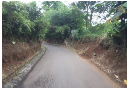
Gambar 2.2 Jalan Utama Menuju Lokasi (Sumber: Koleksi Pribadi)
