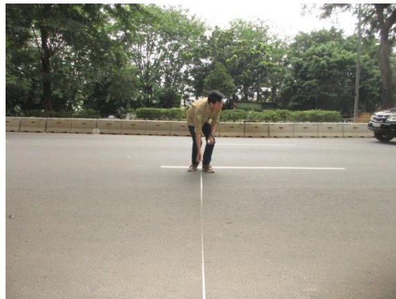
Gambar 14. Pengambilan Data oleh Surveyor dan Pengambilan Data Fisik Jalan
