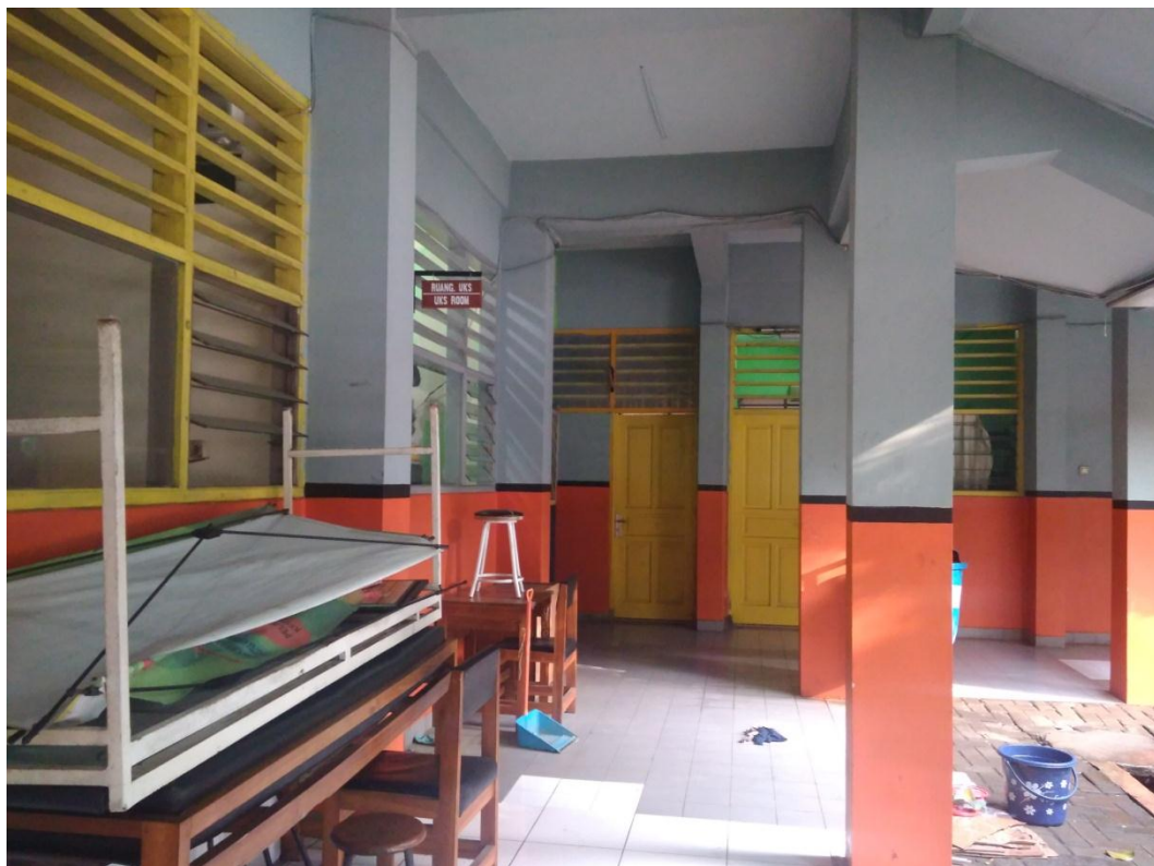
Gambar 10. Ruang UKS yang sedang direnovasi
