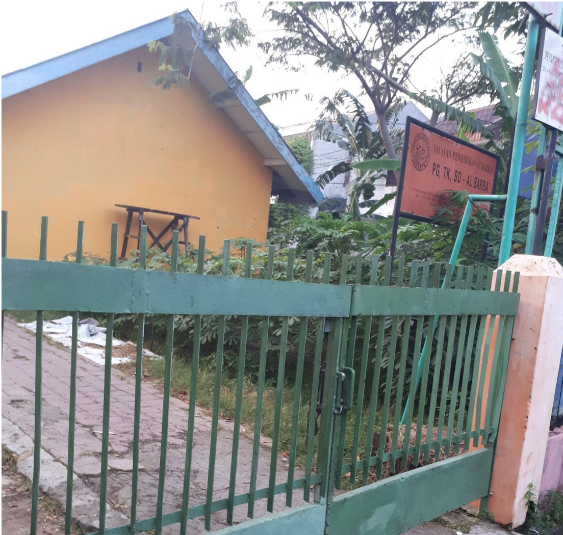
Gambar 4.1 Tampak Depan SDS Al Barra, Utan Kayu Selatan. (CD01)
