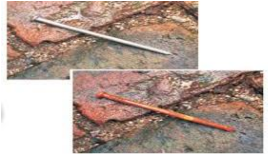
Gambar 2.11 Proses korosi pada paku
