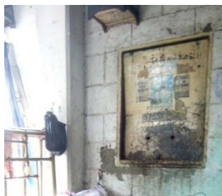
Tempat Penampungan Sampah di tiap lantai Rusun (CD 52)
