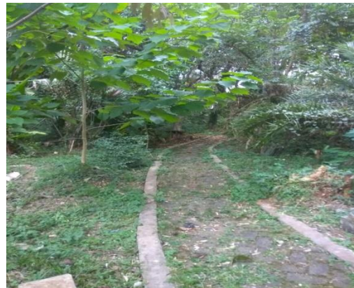
Gambar 28. Kondisi jalan setapak yang tidak difungsikan
