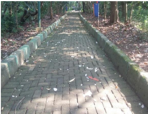
Gambar 15. Jalan setapak menuju danau
