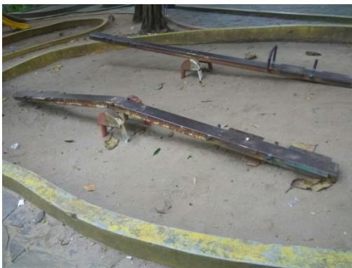
Gambar 21. Kondisi jungkitan yang rusak
