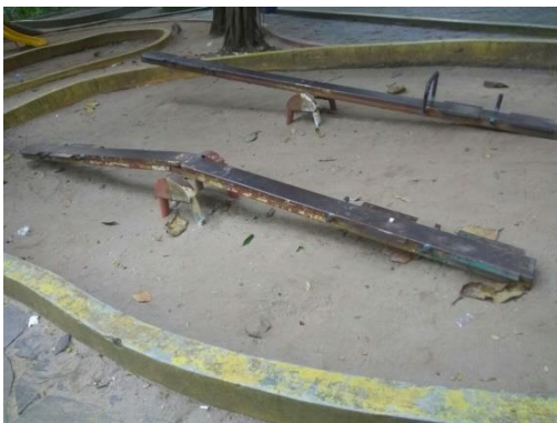
Gambar 21. Kondisi jungkitan yang rusak
