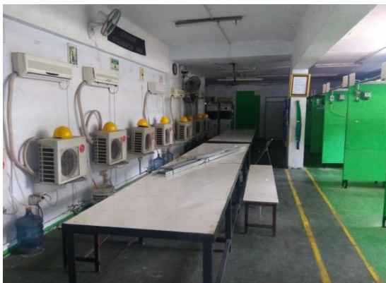
Bengkel Listrik Tenaga
