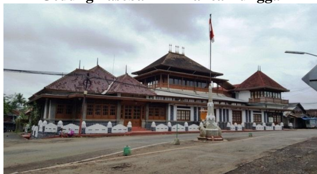
Gambar II.3. Gedung Paseban Tri Panca Tunggal
