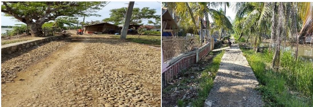
Gambar 2.6 Akses Jalan yang berada di Desa Pantai Bahagia
