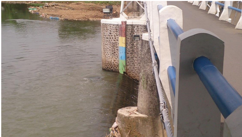
Gambar 2.1. Pintu Air Bendungan Katulampa
