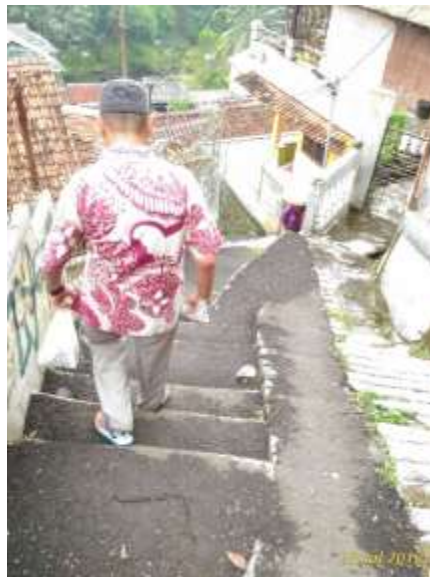
Gambar 2. Akses jalan setapak di permukiman yang rawan longsor
