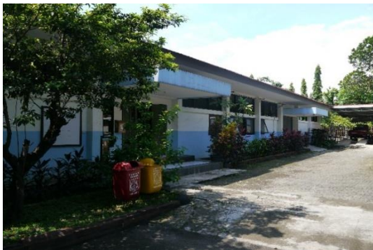
Bangunan Teknik Gambar Bangunan (TGB)
