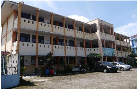
Bangunan Teknik Komputer Jaringan (TKJ)
