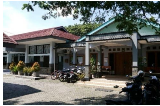
Bangunan Teknik Kendaraan Ringan (TKR)
