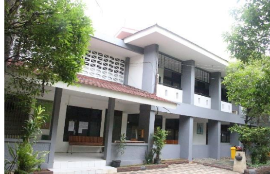
Bangunan Teknik Instalasi Pemanfaatan Tenaga Listrik (TIPTL)
