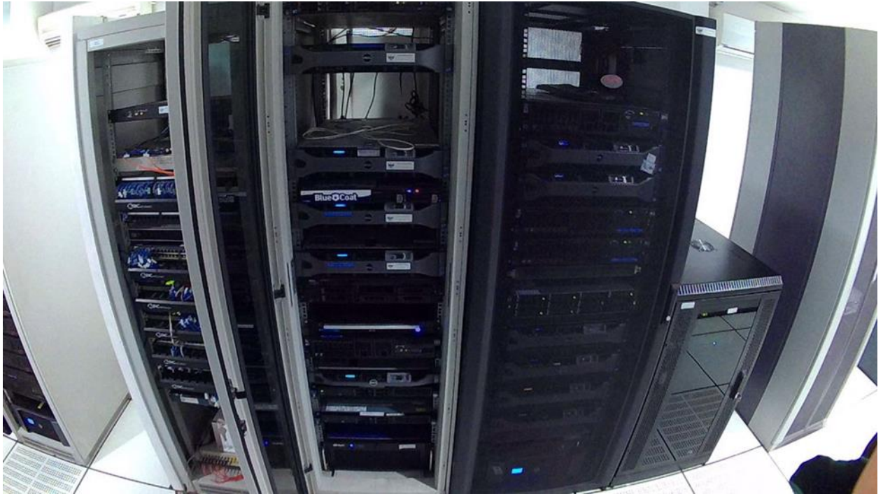
Gambar 5. Ruang Server LAPAN Pusat
