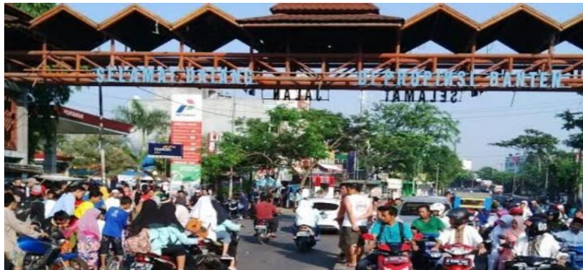
Gambar 2.3 Gardu Perbatasan Jakarta Selatan dan Tangerang di Jalan Ciledug Raya
