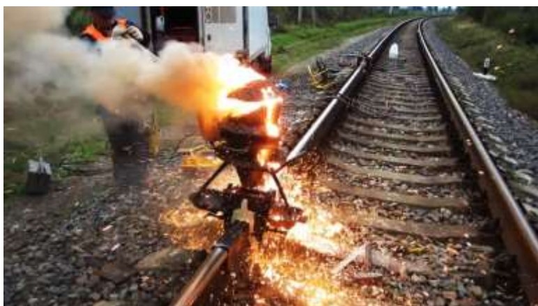
Gambar 5 Proses pengelasan rel kereta api ( jayamanunggal.com )
