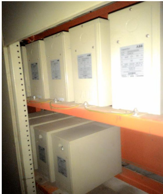
Gambar : Bagian Dalam Panel Capasitor Bank di Gedung Power House PLT Biomassa Bantar Gebang
