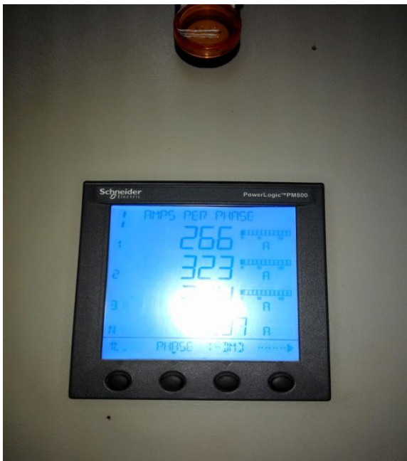
Gambar : Pengukuran Tegangan dan Arus pada Pane LVMDB Auxiliary
