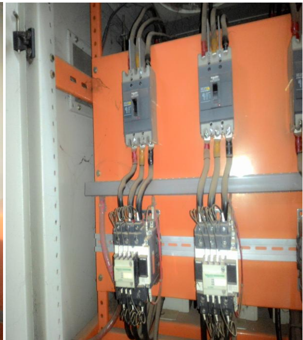
Gambar : Bagian Dalam Panel Capasitor Bank di Gedung Power House PLT Biomassa Bantar Gebang
