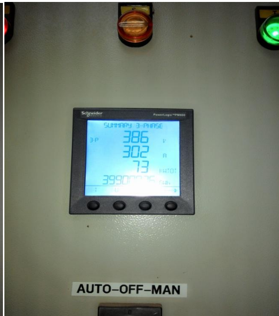
Gambar : Pengukuran Tegangan dan Arus pada Pane LVMDB Auxiliary
