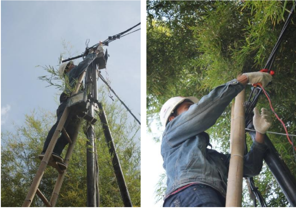
Pengukuran Sambungan Tiang
