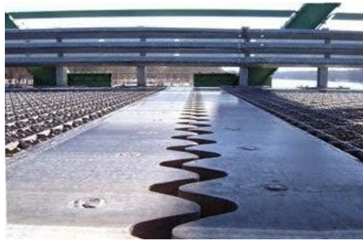
Gambar 2.3 Sambungan dengan prinsip pemuaian termal
