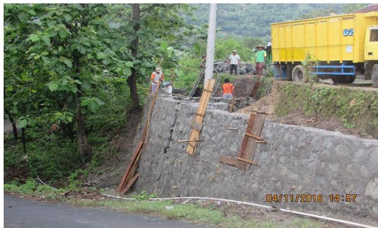
Gambar 4.5 Gotong Royong Pembuatan Talud di Dusun Jelok
