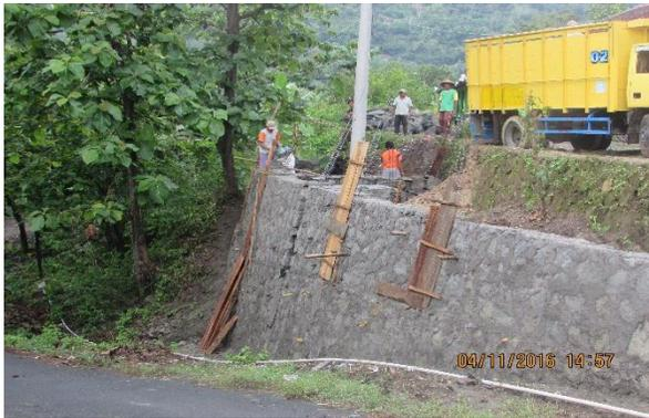
Gambar 15. Kerja Bakti Pembuatan Talud
