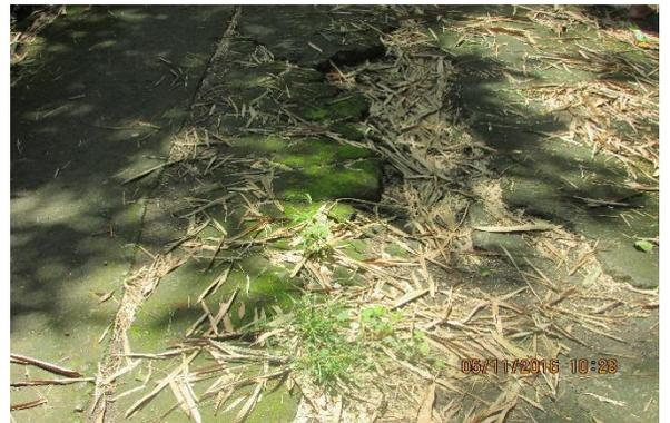
Gambar 18. Jalan yang Retak Akibat Tanah Longsor
