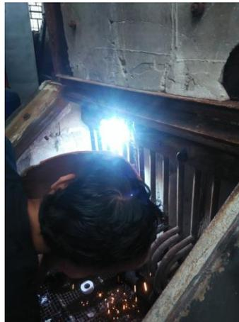
**Gambar 3.12 Pengelasan Pada Pipa Stainlesssteel**
