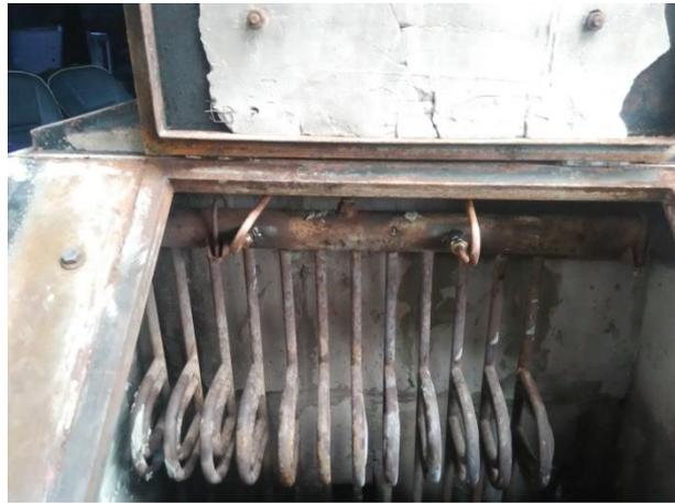
**Gambar 3.14 Pemasangan Pipa Kondensasi Dengan Pipa Heater**
