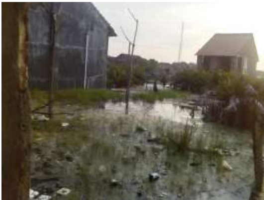
Kondisi belakang rumah Ibu UN
