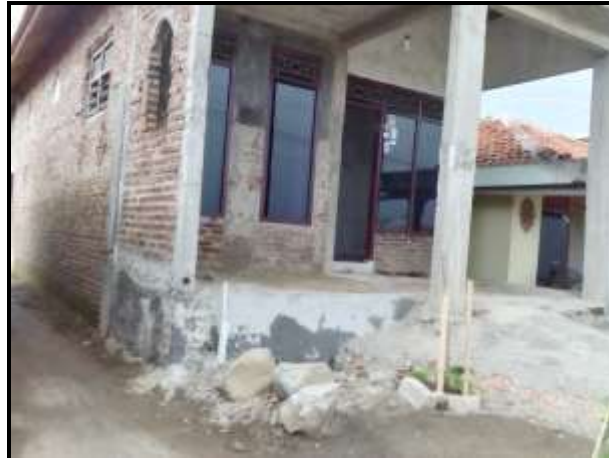
Gambar 3.4 Peninggian Pondasi Rumah
