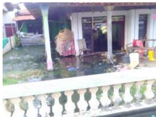
Kondisi salah satu rumah warga di Desa Wonokerto Kulon
