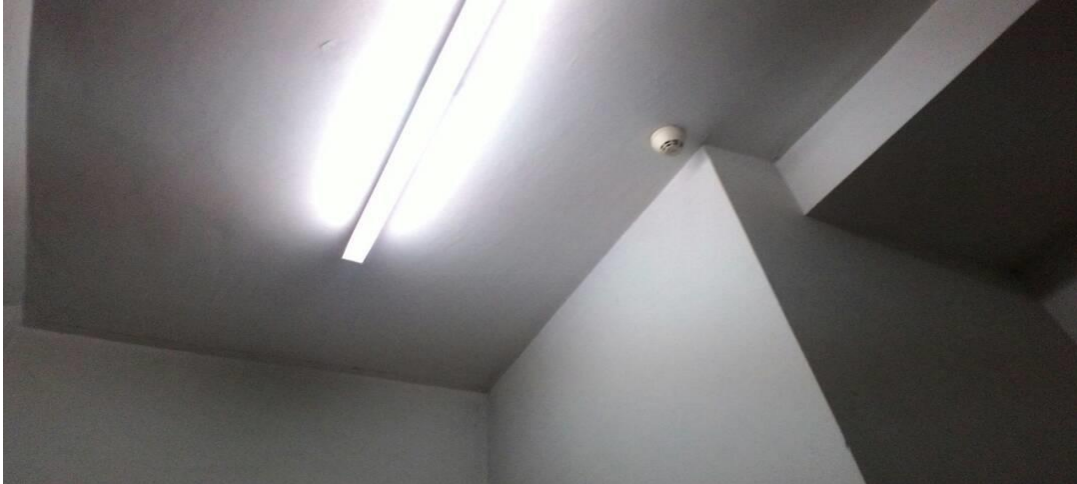
4.15 Gambar Detektor Asap Sumber : Data Penulis
