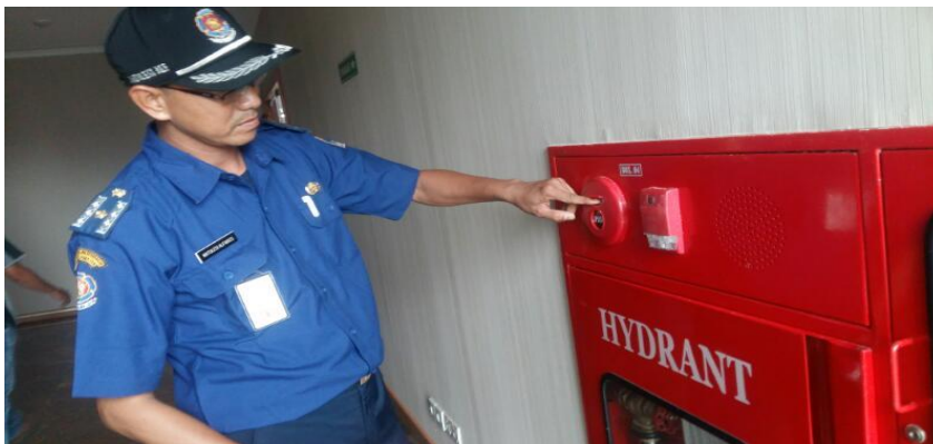
4.6 Gambar Titik Panggil Manual Sumber : Data Penulis
