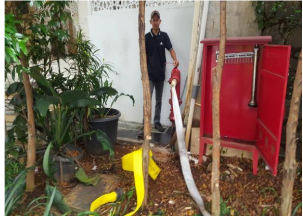
4.10 Gambar Hidran Pilar / Hidran Halaman Sumber : Data Penulis
