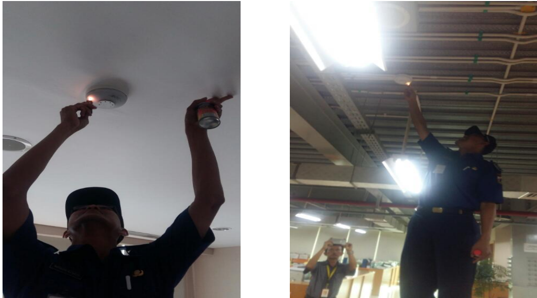
4.4 Gambar Pengujian Detektor Panas Sumber : Data Penulis
